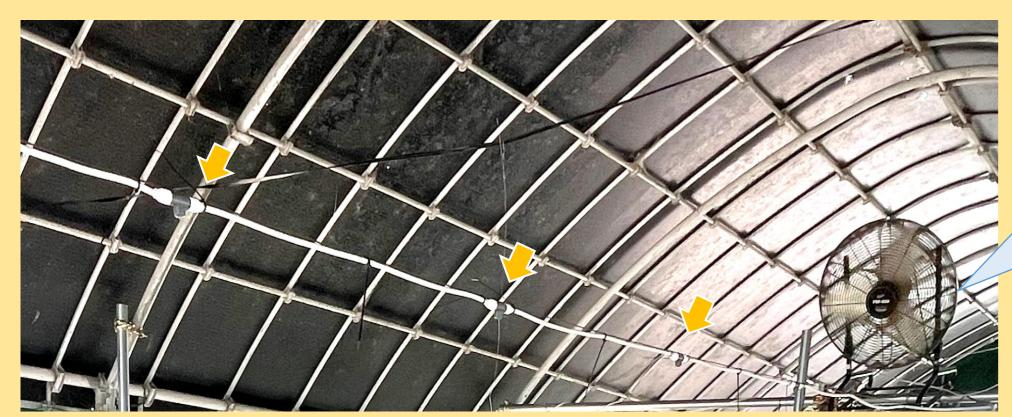
扇風機でミスト が拡散するよう に設置
